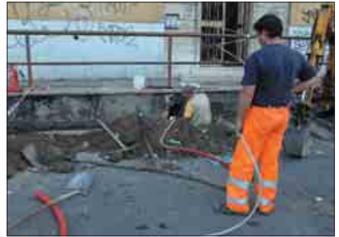
Lavori in un cantiere del centro. In città sono in corso numerose opere di asfaltatura
